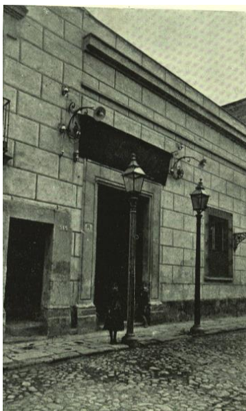
Imagen 2: “Faroles y Columnas de Gas Hidrogeno y ménsulas de luz incandescente, calle de las moras CD, MX. Finales siglo XIX”
